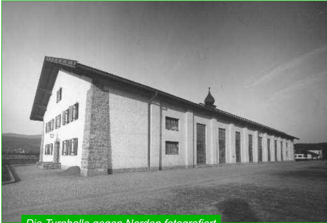
Die Turnhalle gegen Norden fotografiert
