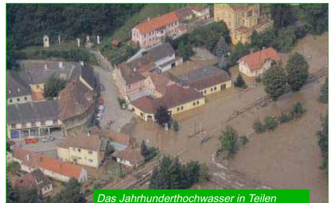
Das Jahrhunderthochwasser in Teilen Ober- und Niederösterreichs 2002
